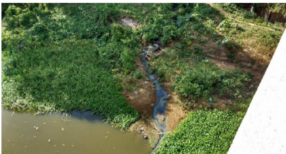
Figura 2: Visão geral da ponte da BR-408, resíduos despejados no Rio Tracunhaém.
